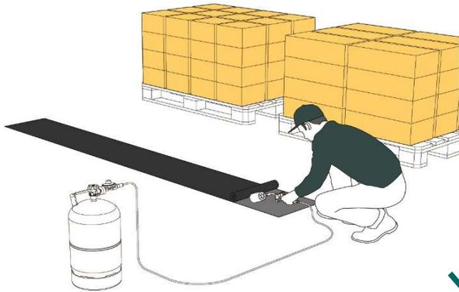
Ensuite, la bande de bitume découpée est posée et chauffée pour que la bande soit solidement fixée au sol. Chaque bande doit se chevaucher de 15 cm.
