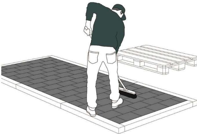
Sobald die Fläche vollständig bepflanzt ist, inklusiver aller Randsteine, muss die Fläche sauber gefegt und trocken sein, dann kommt das Fugenmaterial zum Einsatz. Eine vollständige Fugenfüllung ist die wichtigste Voraussetzung für eine dauerhaft funktionsfähige Pflasterfläche. Das Fugenmaterial muss stabil sein, damit die Lastübertragung von Stein zu Stein gewährleistet ist. Es empfiehlt sich Sand oder Splitt zu verwenden.
