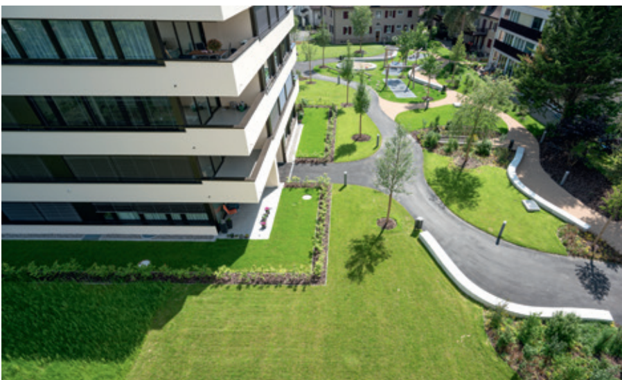
DER FELSENSTIEG AUS DER LUFT. Im Norden von Schaffhausen hat die Göldi AG unter Leitung von Dominic Ortli diesen öffentlichen Raum angelegt und bepflanz
